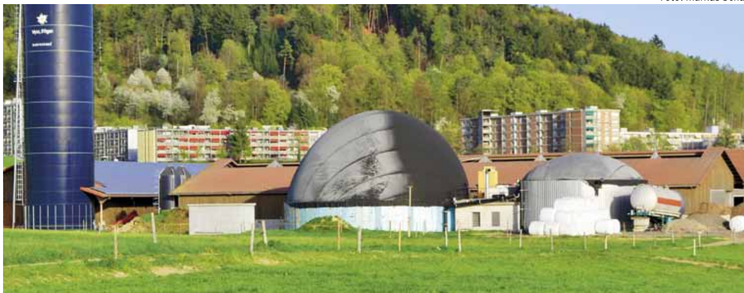
Biogasanlage auf Bauernhof in Ittigen/BE.
