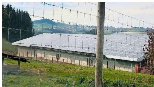
Geschlossene Türen trotz Sonnenschein: Betrieb in Wald AR
